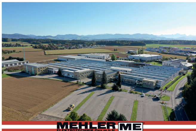
Foto: MEHLER Elektrotechnik Ges.m.b.H
